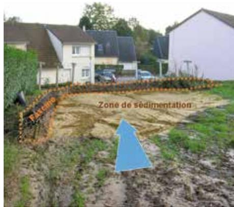
Figure 8 : Entre deux champs ou à l'amont d'une zone urbanisée, les fascines permettent de ralentir les écoulements et de retenir les matières charriées par les flots, limitant ainsi les coulées d'eau boueuse. Photo d'origine : AREAS.
