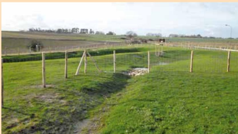
Figure 11 : Un espace pour la rétention des eaux pluviales à proximité d'un lotissement neuf en Seine-Maritime. L'ouvrage, constitué de plusieurs bassins en cascade, permet de rejeter les eaux ruisselées au milieu naturel avec un débit contrôlé. Photo : SMBVAS.
